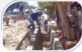
پروژه‌های منطقه شش ۳۴۵ میلیارد ریال
