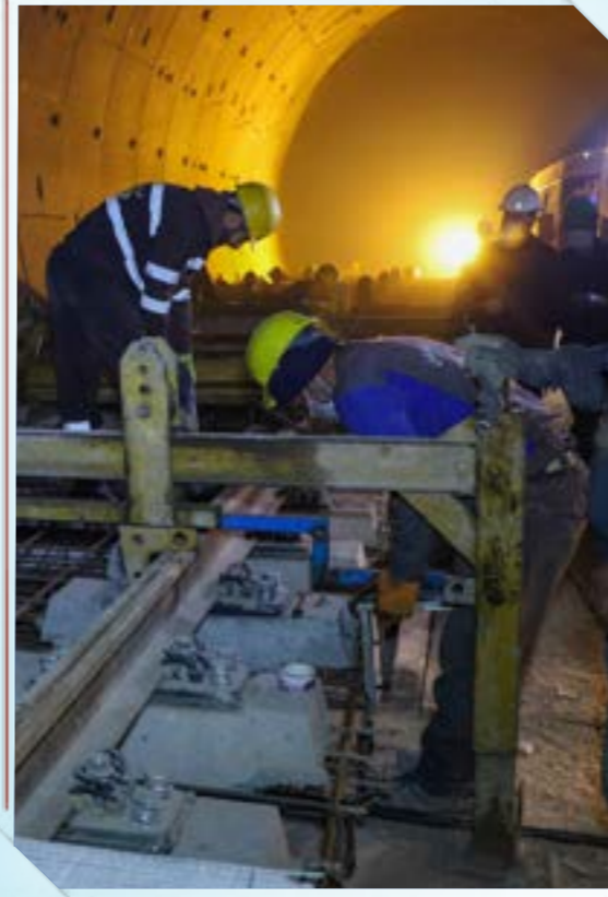
ریل‌گذاری خط یک متروی قم - خرداد ۱۴۰۰
