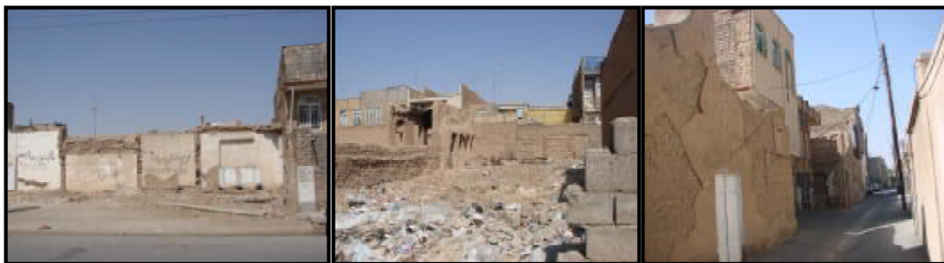
تصویر شماره 7- 13: فرسودگی بافت محله و ساختمانها به خصوص در شمال غرب محدوده و استفاده فعلی از مخروبه‌ها به عنوان مکان تجمع زباله
