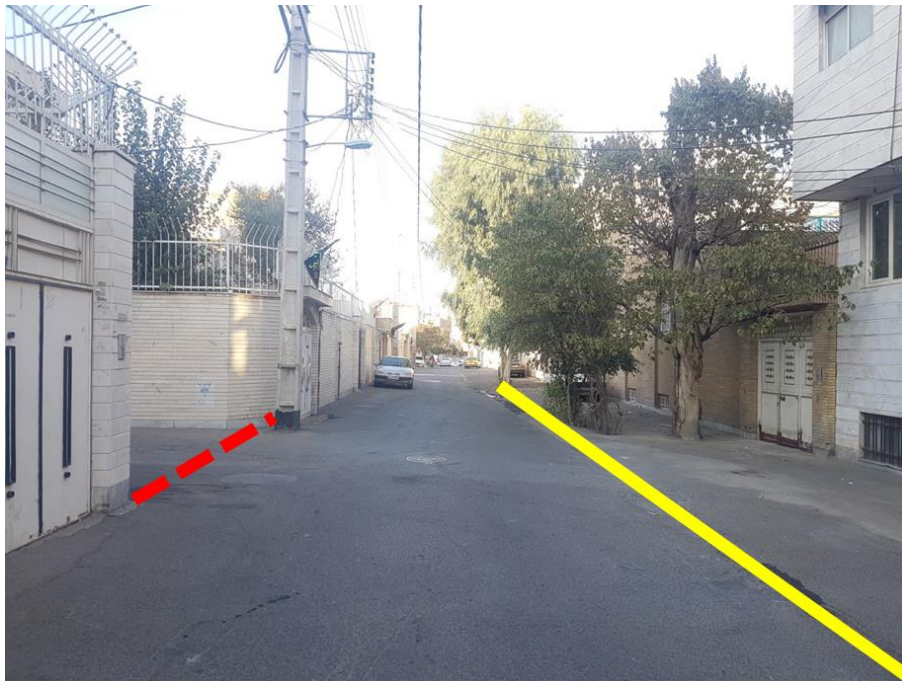
شکل ۳-۱ نمونه ای از مشکل ایمنی نوع ۱- نامشخص بودن حریم پیاده رو و سواره رو
